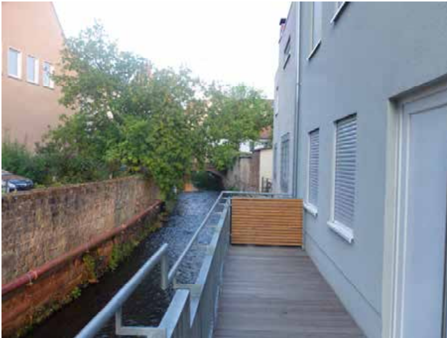
Abb. 64: Queich zwischen Kronstraße und Klosterbrückchen
