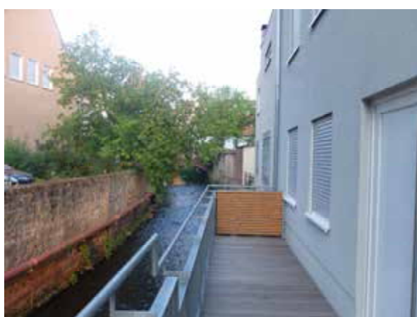
Abb. 39: Queich zwischen Kronstraße und Klosterbrückchen
